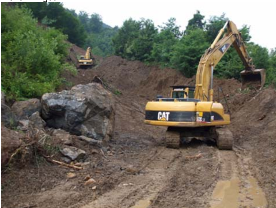
Slika 1. Izgradnja pristupnog puta prema ležištu dijabaza „Kuluk“ Begov Han
